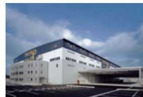
東海ロジスティクスセンター
