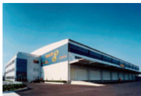
小牧ロジスティクスセンター
