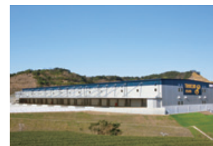
C 静岡ロジスティクスセンター
