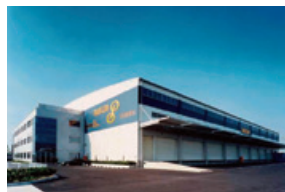
小牧ロジスティクスセンター
