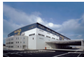
東海ロジスティクスセンター
