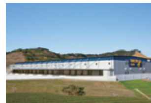
C 静岡ロジスティクスセンター
